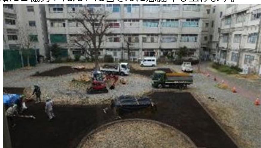
中庭整備工事の様子(2026 年 3 月)
